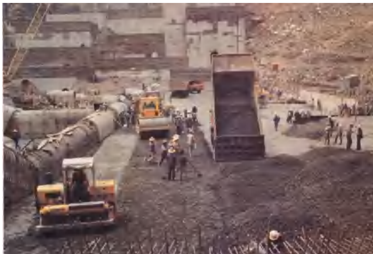
图 2-56 某碾压混凝土重力坝施工现场
