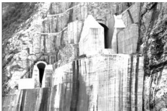
图 7-22 隧洞出口窄缝挑坎消能图 (高程单位:m;尺寸单位:cm)
