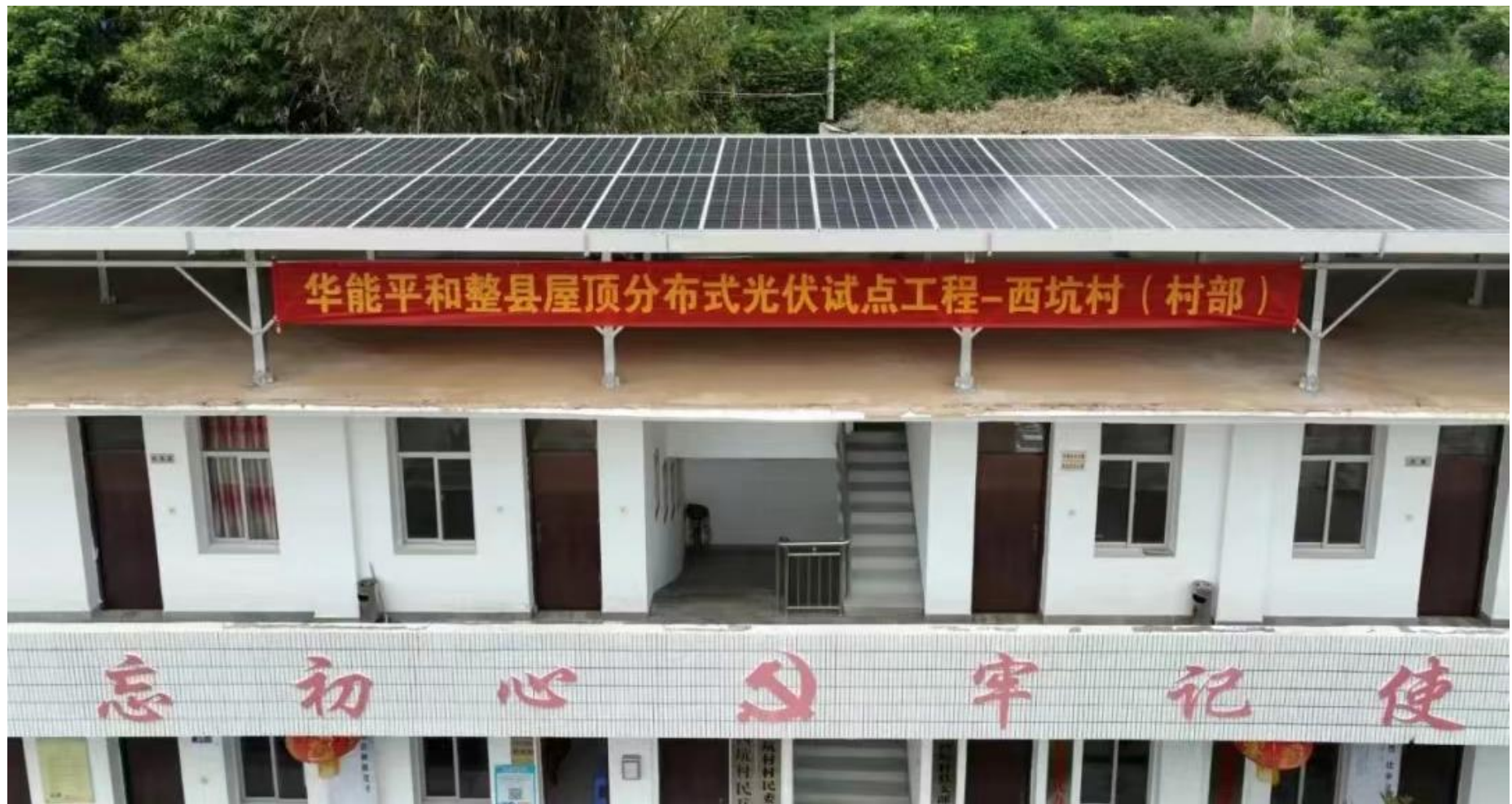
漳州平和整县开发分布式光伏项目
