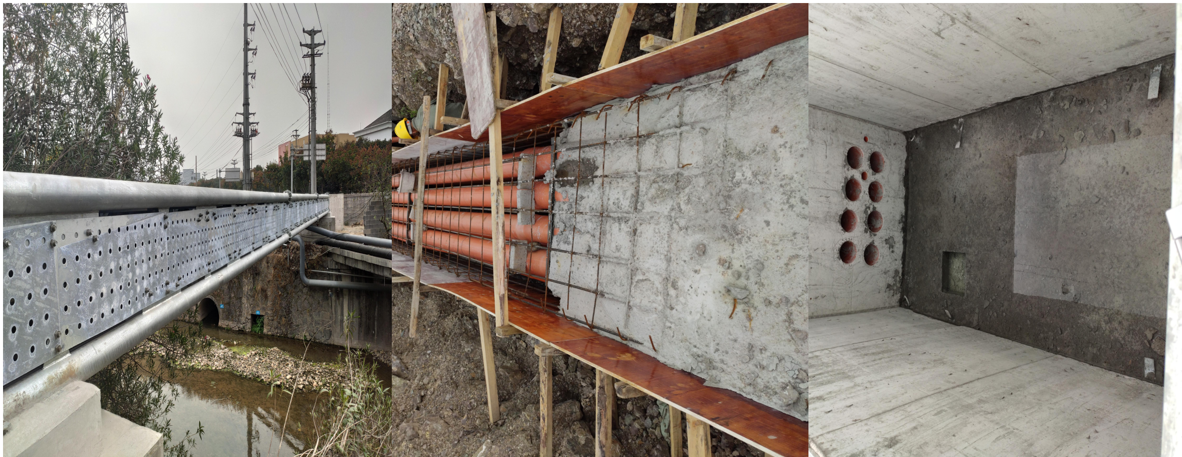
丽水金亭变220kV变电站35kV送出工程、电缆桥架设计、电缆排管施工
