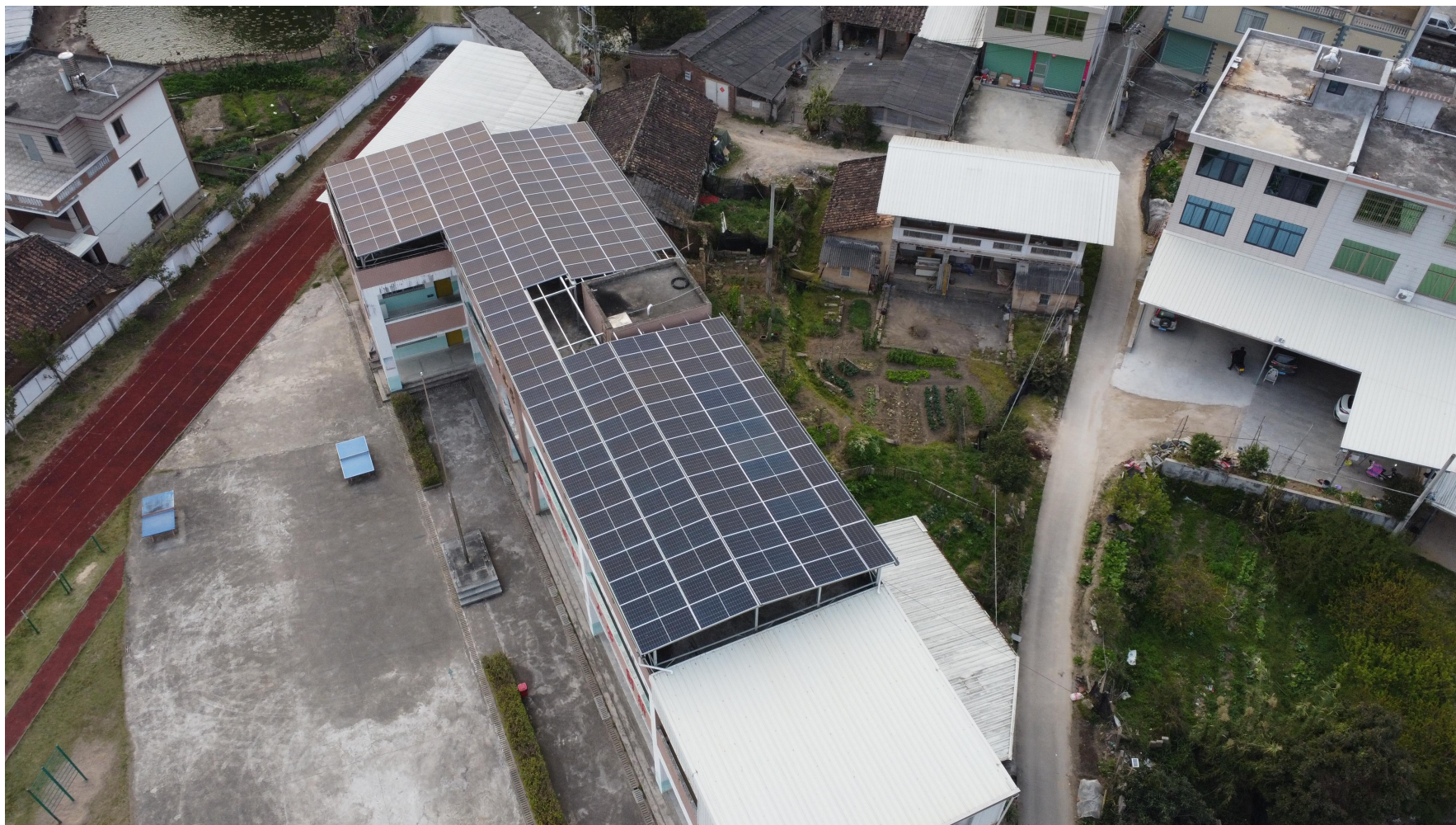
漳州平和县文峰镇三坪小学79.2kWp分布式光伏发电工程
