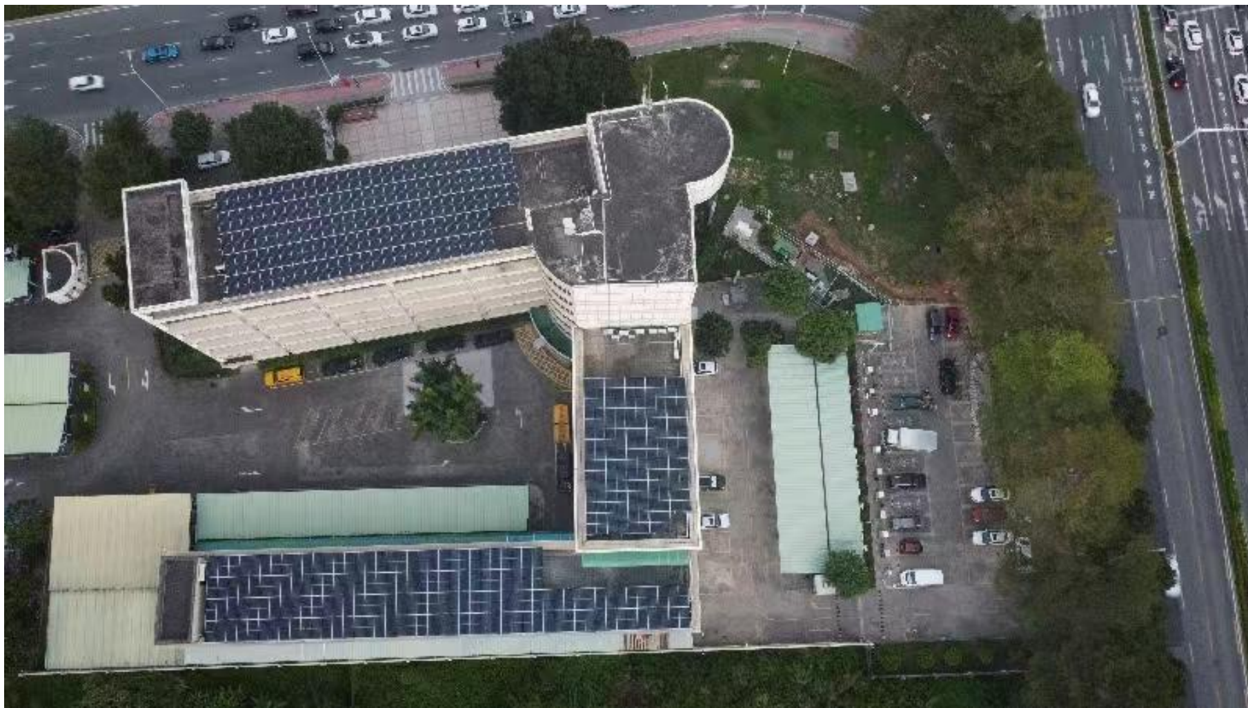
中山供电局东区供电分局办公楼智慧能源示范项目
