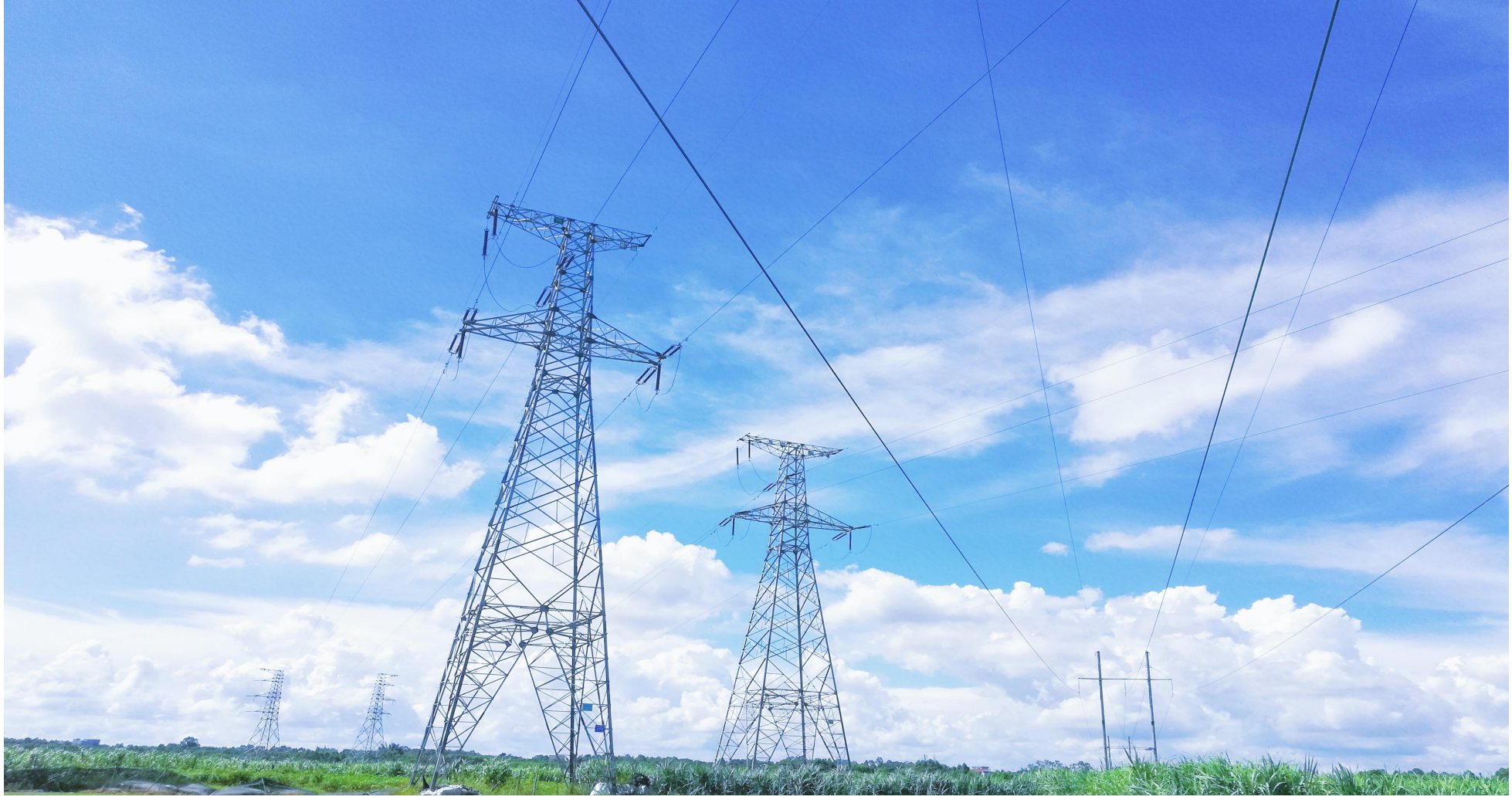
合湛铁路迁改工程
