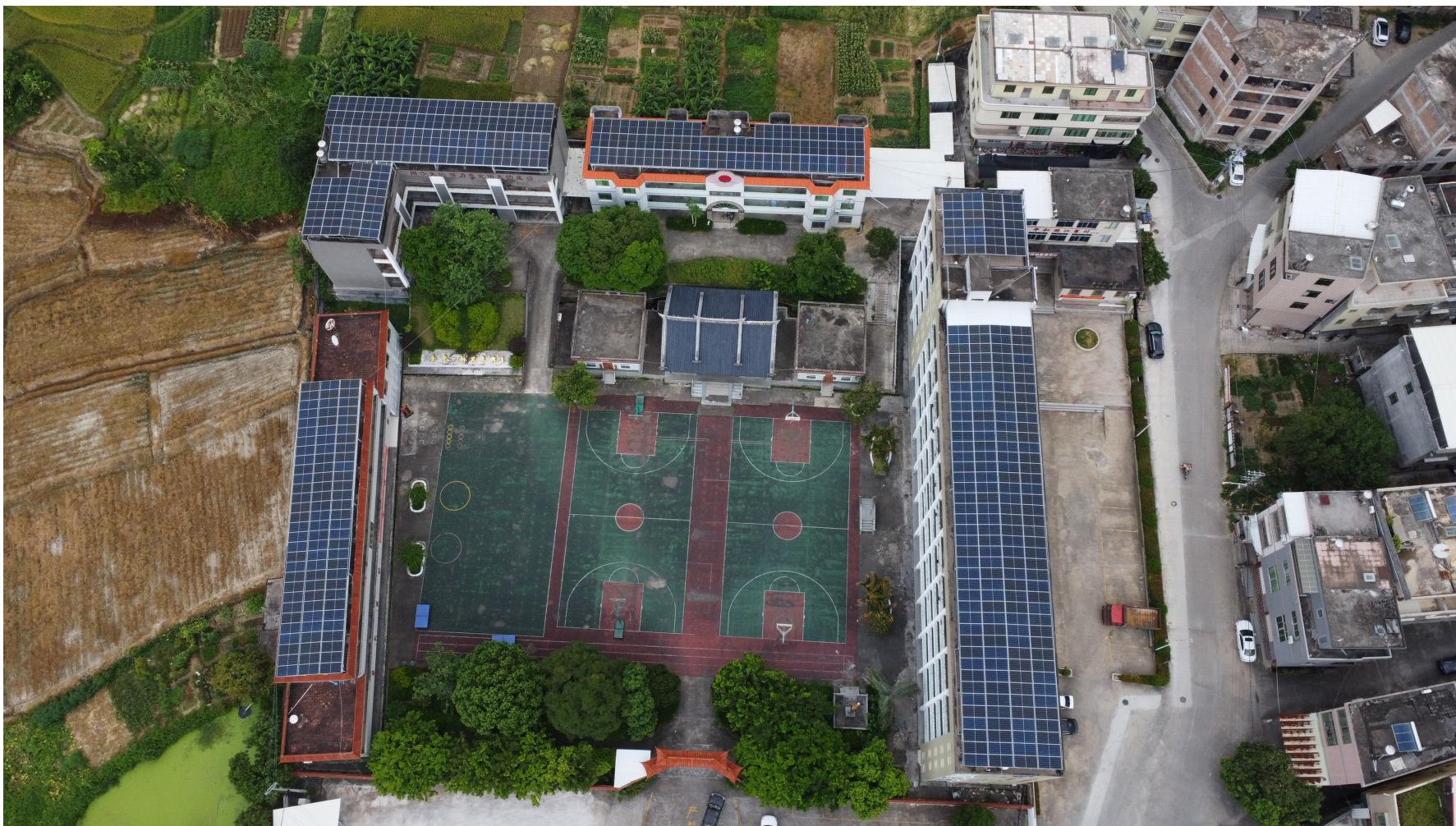
漳州平和县大溪镇江寨小学272.8kWp分布式光伏发电工程
