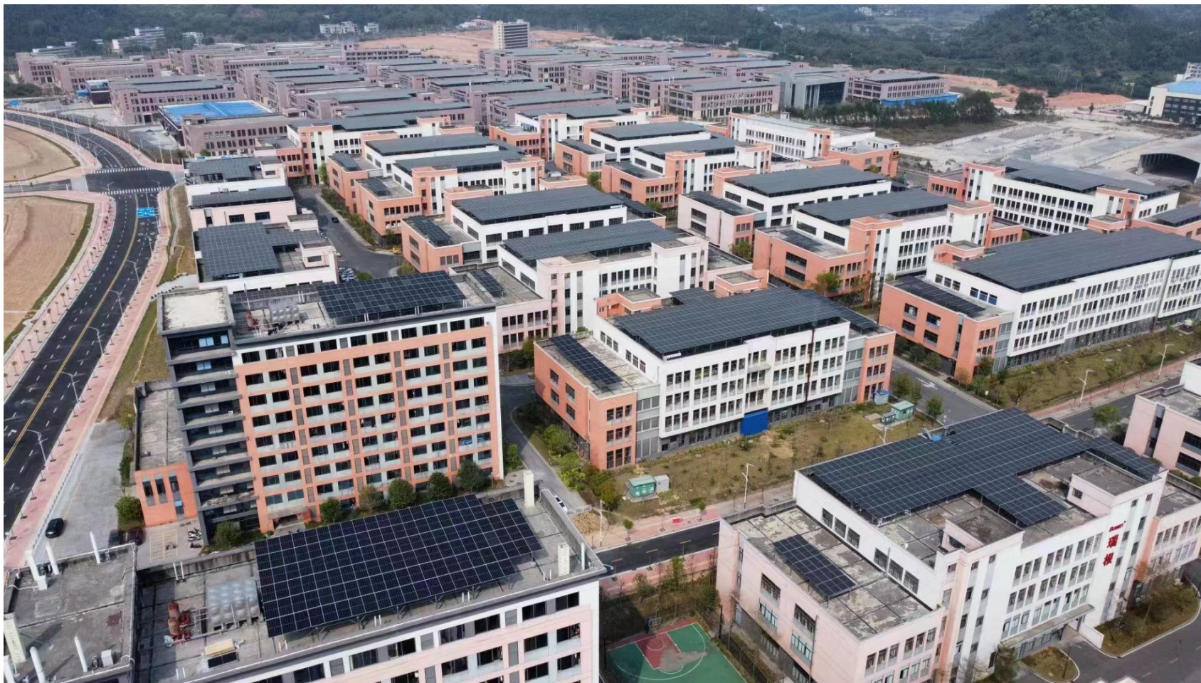
华电肇庆封开平风15.7505MWp屋顶光伏项目
